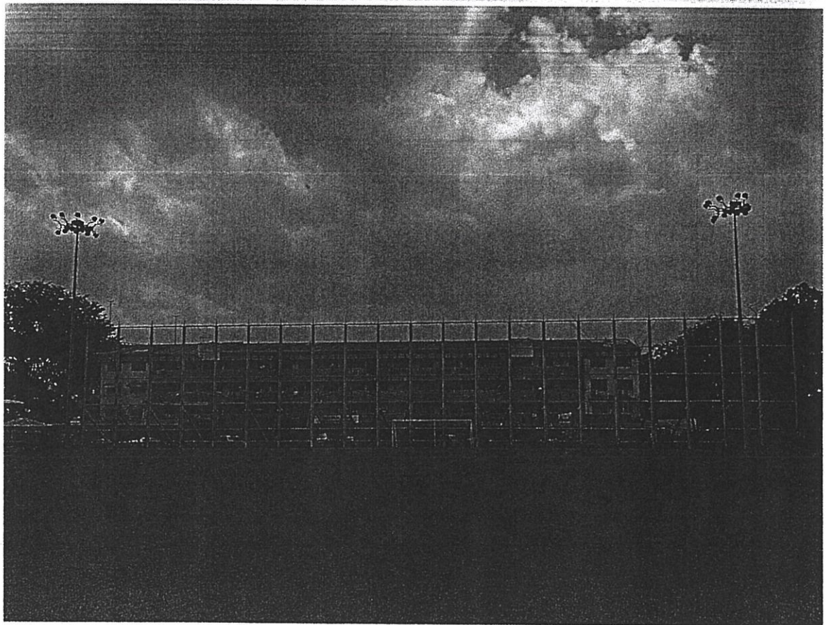
LOKASI TIANG DAN LAMPU
